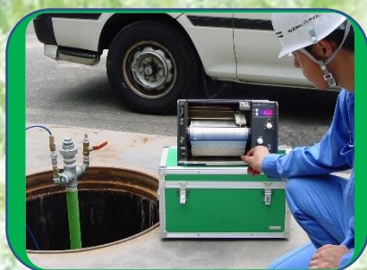
気相部漏洩検査用圧力レコーダー
