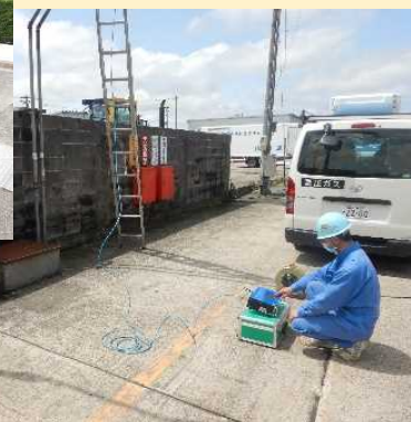
現場での地下タンク漏れ検査風景
