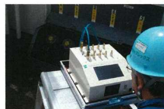
地下タンク検査
