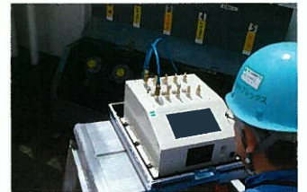
地下タンク検査
